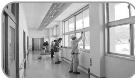
住宅清掃作業
