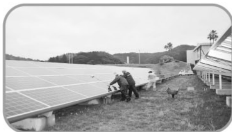
太陽光パネル清掃作業
